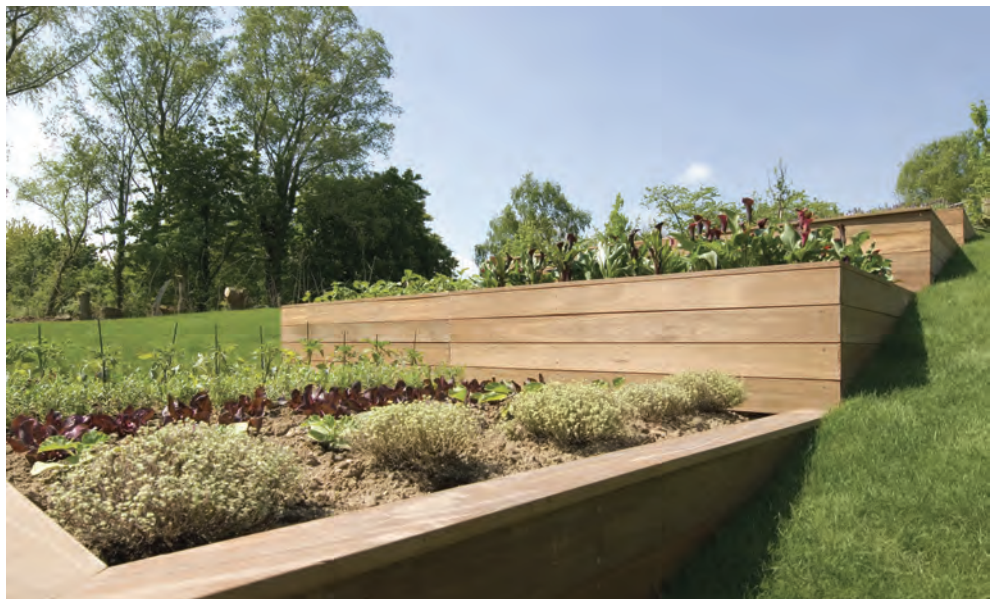
Toepassing van hout bij hoogteverschillen
