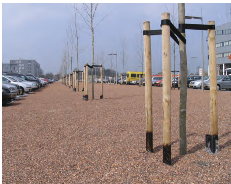
Boompalen, plaatselijk verhit
